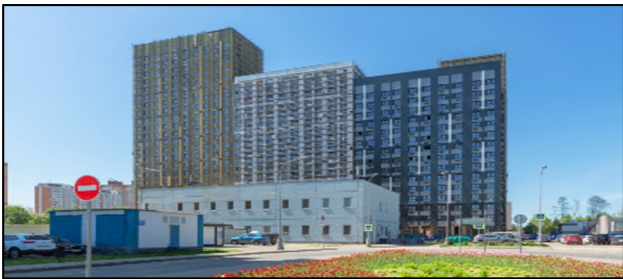
Рисунок 2 — Модульный жилой комплекс на 9-й Северной линии, Москва
