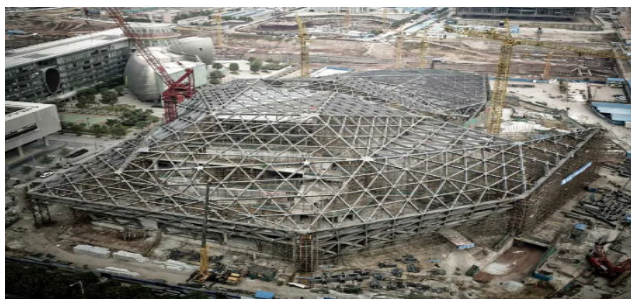
Рис.3 Оперный театр в Гуанчжоу, процесс строительства.
