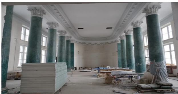
Рисунок 3. Казанский аэровокзал. Интерьер в процессе реставрации. Фото Л.Ивановой. 2026
